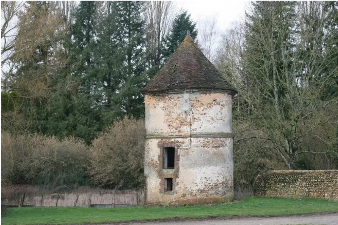
Le colombier de Dilo, un édifice qui mériterait d'être conservé. © Droits réservés
